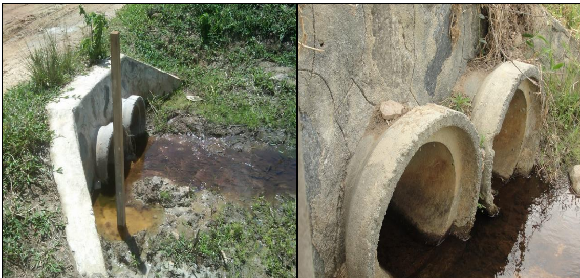
Figura 11 Ilustração do bueiro condutor localizado na microbacia Natuba3.
