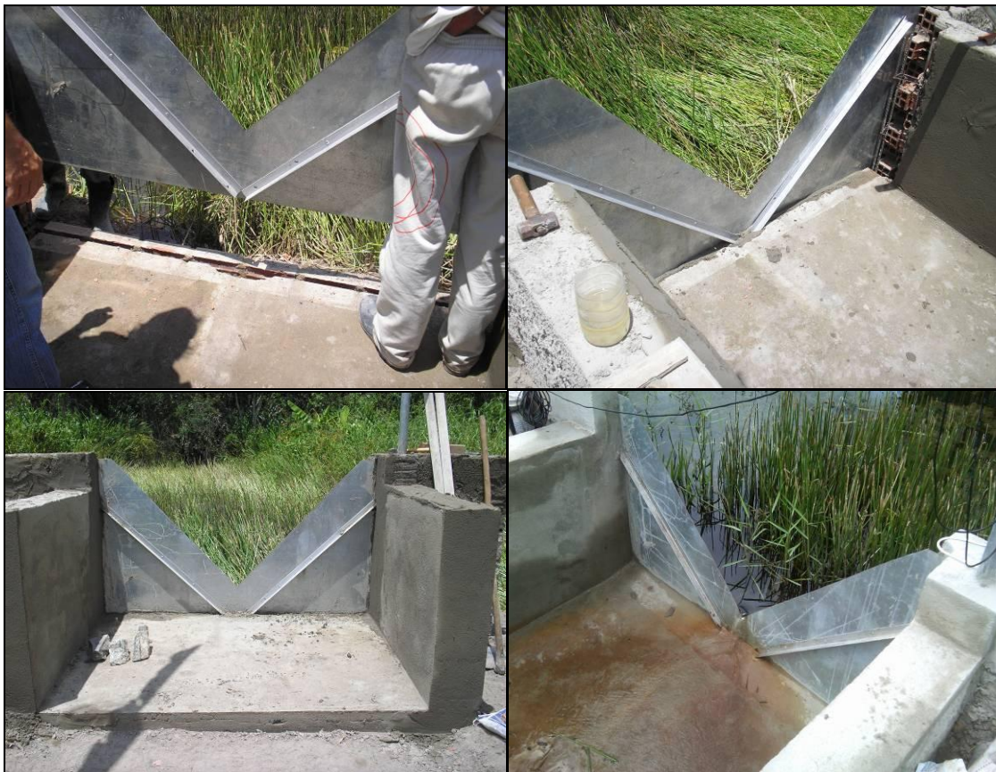
Figura 10 Seqüência de instalação até o funcionamento de um vertedouro portátil tipo os do USGS.
