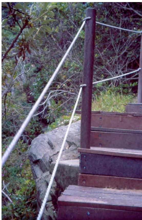
Figura 5.2. Exemplo de utilização de estruturas de plástico num parque na África do Sul.
