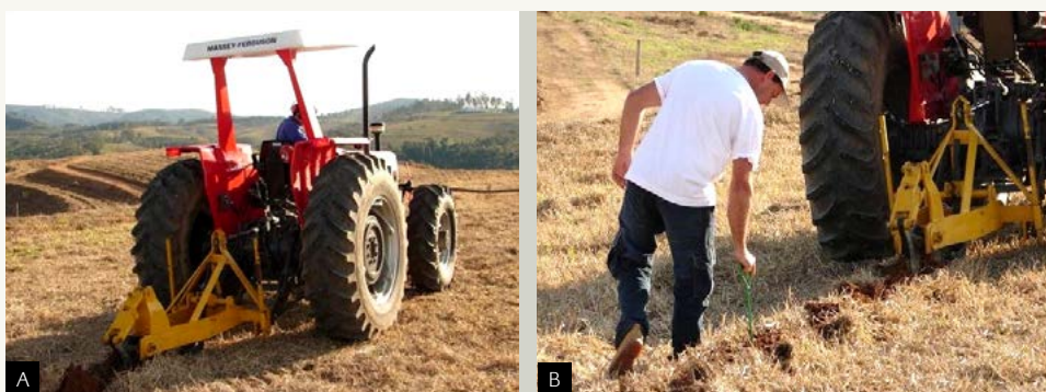
Figura 21: Área com o mato já seco, após aplicação de herbicida, sendo preparada para o plantio com um subsolador florestal (A) e técnico medindo a profundidade de subsolagem com uma haste de ferro (B).
