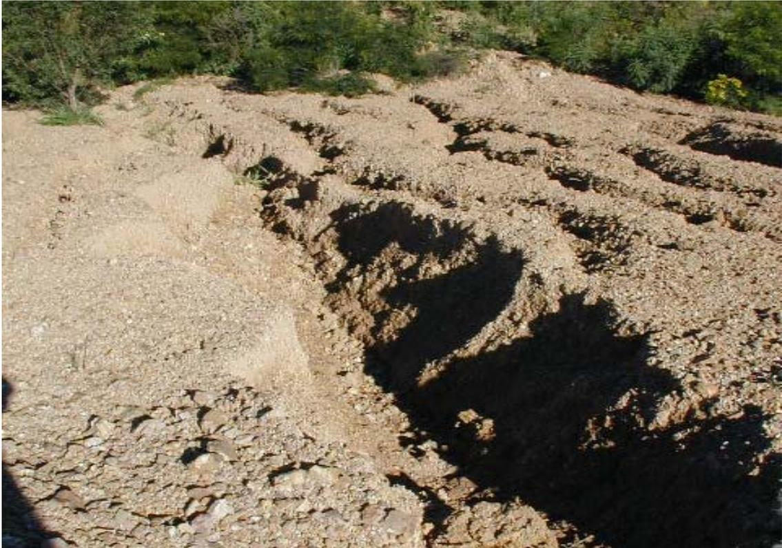
Figura 5 – Detalhe de erosão do subsolo usado na construção dos taludes, sem nenhuma regeneração natural após o período chuvoso, Fazenda Intermontes - CCRG, município de Ribeirão Grande, SP
